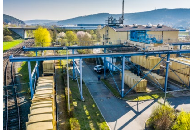
An den Umladestationen in Kronach-Neuses und Lichtenfeld-Seubelsdorf wird der Müll vom Lkw auf die Bahn verladen.
